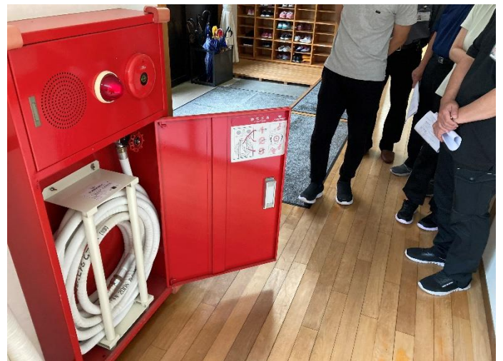
<消火設備の確認の様子>
