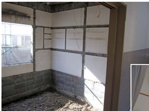
▲ 安倍寮居室改修 改修の様子
