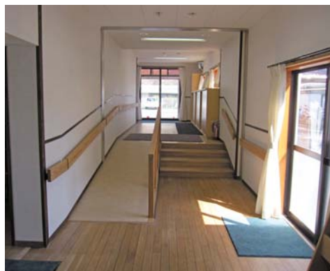
安倍寮改修後の中央廊下の様子 スロープを設置しました
